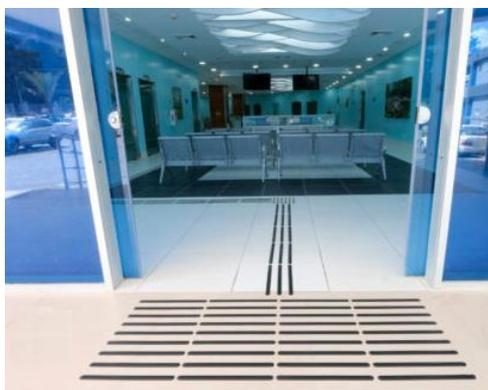
Guías autoadhesivas para encaminamiento y avisos podotáctiles
