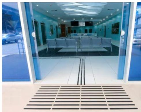
Guías autoadhesivas para encaminamiento y avisos podotáctiles
